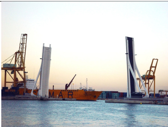
Puente ferroviario levadizo, demolido
