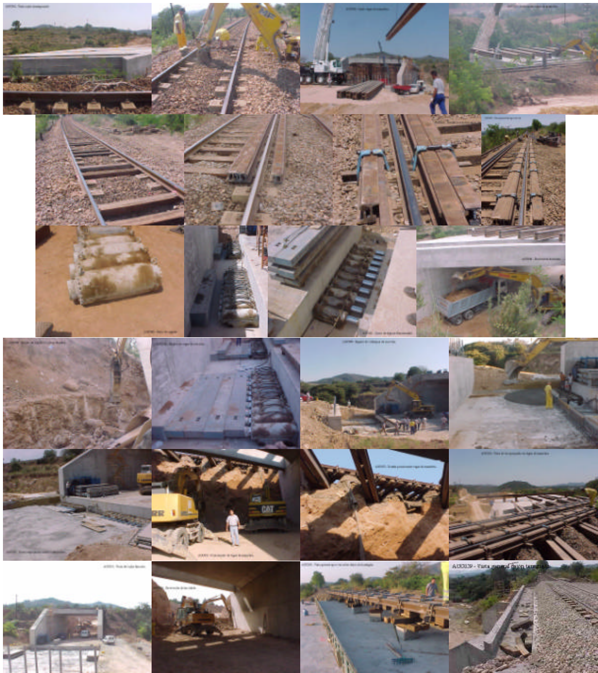
Fig. 2 Fases de apeo de vía, empuje del cajón y excavación de tierras.
