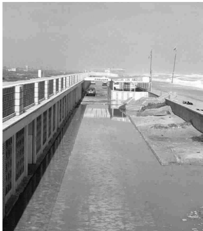
Figura 3. Inundación paseo marítimo El Saler (Valencia)
