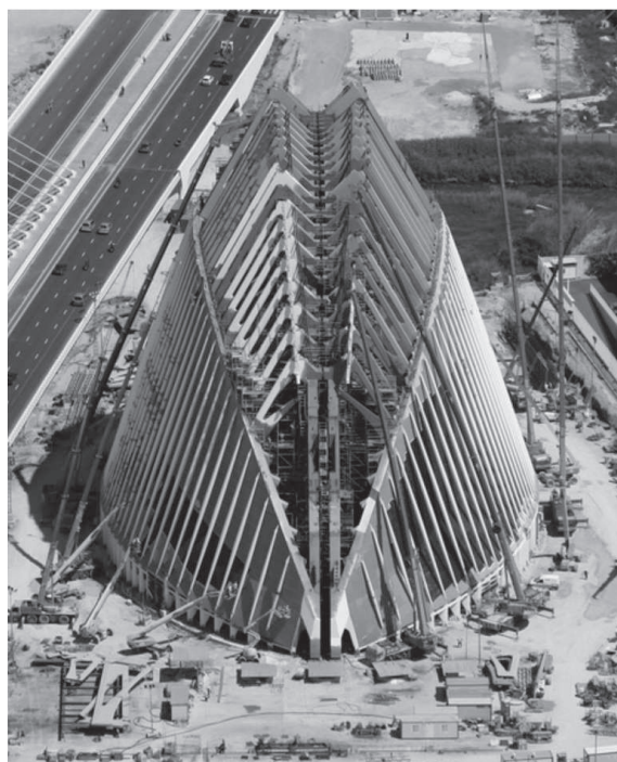
Figura 1 Vista aérea del Ágora en construcción (Fuente: BECSA)
