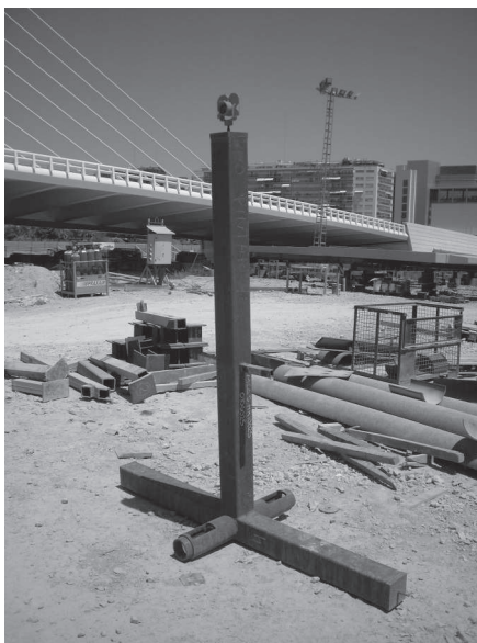
Figura 5 Fotografía del útil empleado para el control geométrico y replanteo (Fuente: BECSA)
