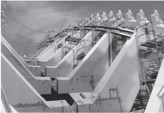
Figura 4 Arranque del arco S5 apoyado sobre las piezas 3/4/5 (Fuente: BECSA)
