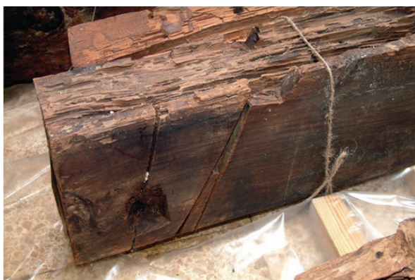
Figura 9. Jaldeta de madera con hendiduras con diferente inclinación para la introducción de las tabicas. La jaldeta, por tanto, ha sido reutilizada y además ha cambiado su inclinación. Iglesia Parroquial de Benifassá (Castellón). Fotografía: C. Mileto y F. Vegas.
