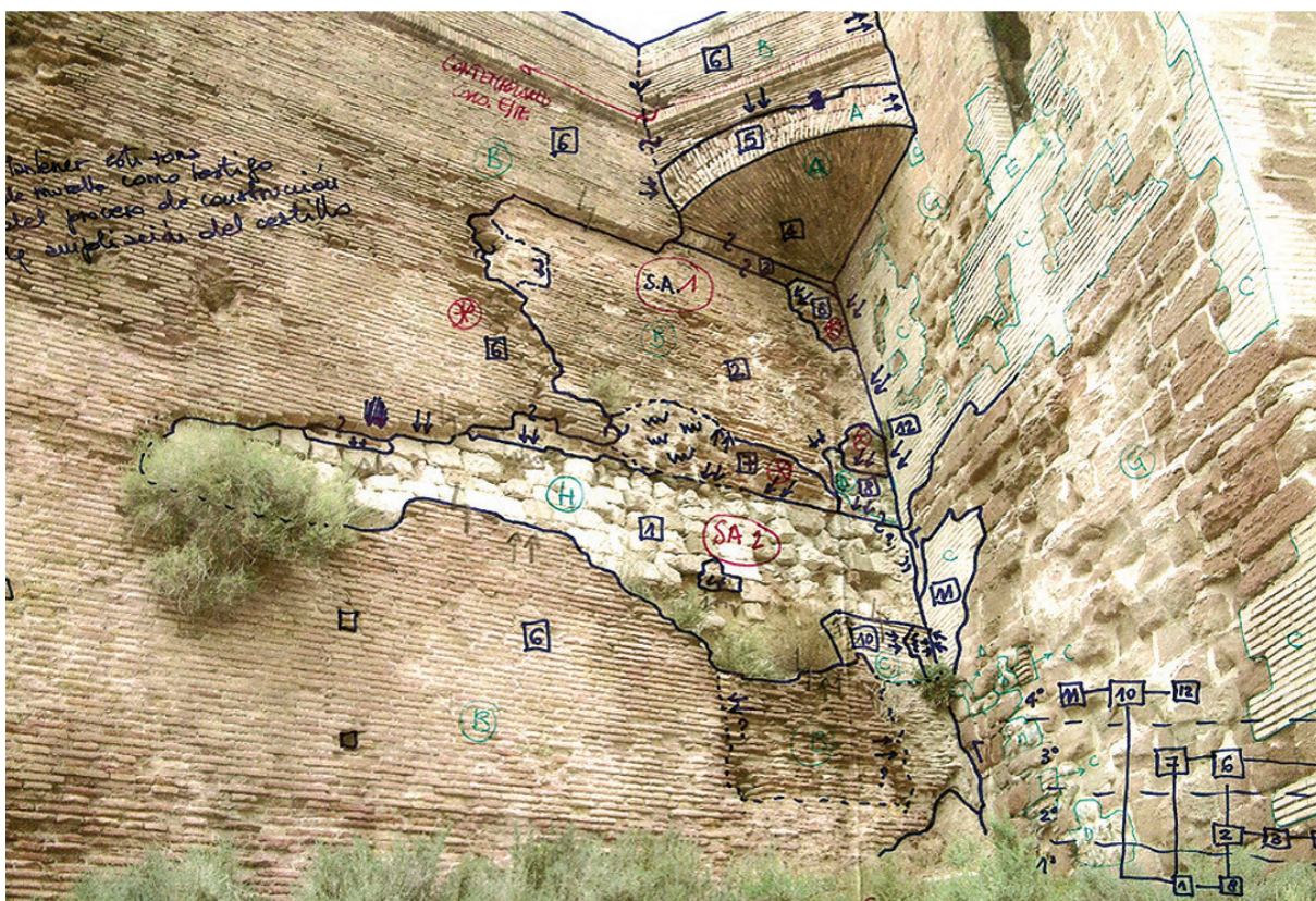
Figura 6. Croquis de campo de un levantamiento estratigráfico. Castillo de Monzón (Huesca). Autores: C. Mileto y F. Vegas.
