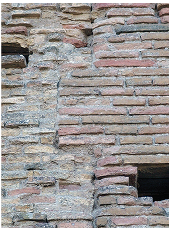
Figura 4. Relación estratigráfica se adosa / se le adosa (el muro de la derecha se adosa al de la izquierda). Castillo de Monzón (Huesca). Fotografía: C. Mileto y F. Vegas.
