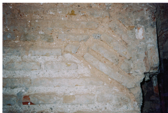
Figura 8. El mortero como material húmedo documenta todo tipo de transformación. En este caso el mortero blanquecino de la fábrica inferior demuestra la contemporaneidad entre ésta y la fábrica superior. Sala de la Barbería en la Alhambra de Granada. Fotografía: C. Mileto y F. Vegas.
