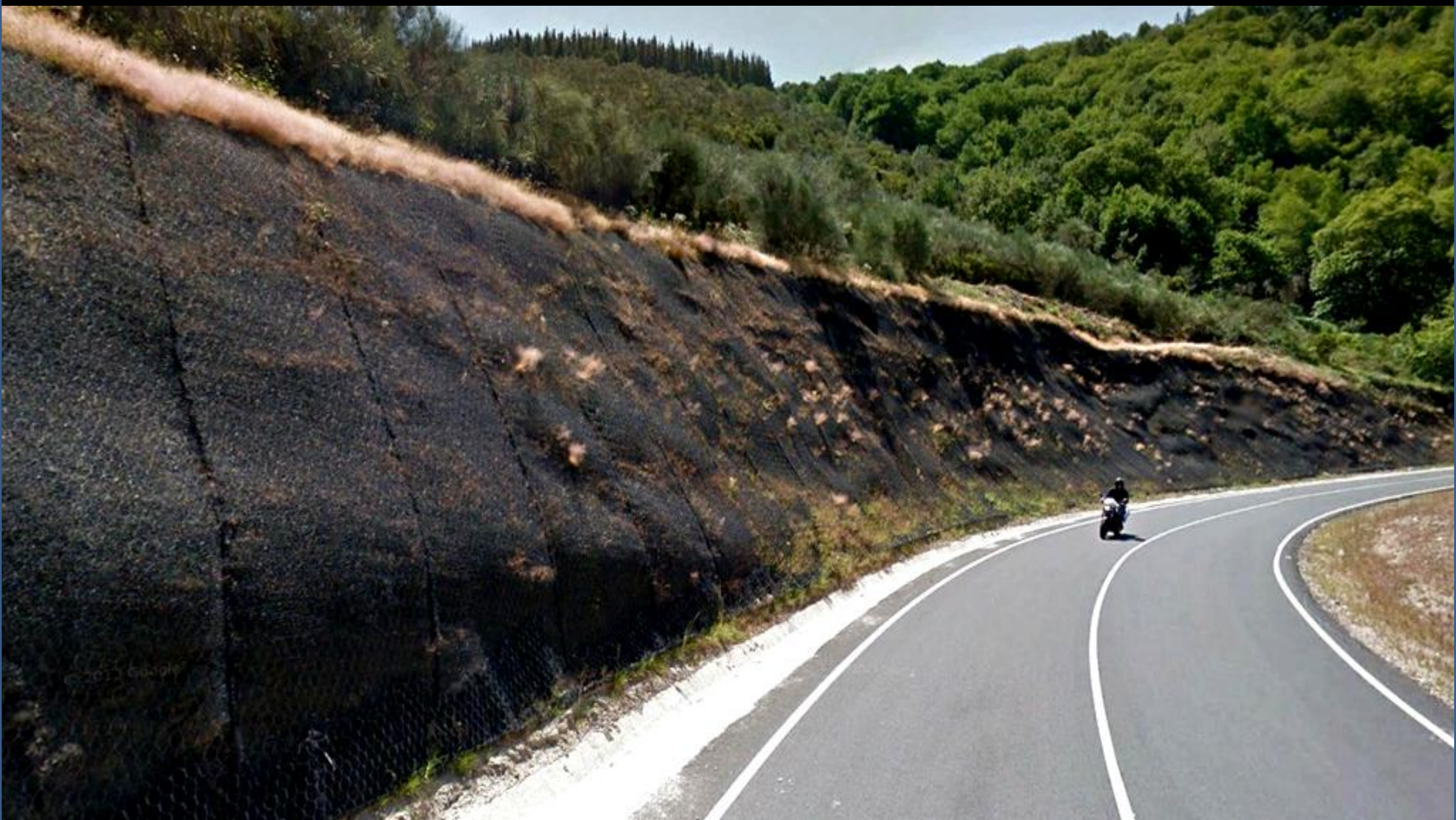
Mallazo para estabilizar el talud en las pizarras negras del Ordovícico Med. NE de Souto, Lugo. Centro Hoja de Becerreá.
