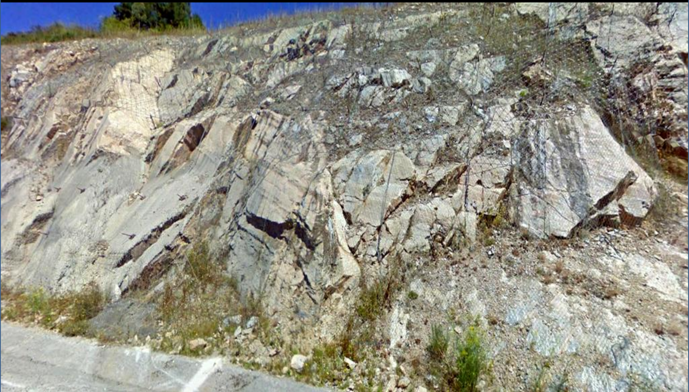
Areniscas Cámbrico- Ordovícicas con mallazo y bulones. Autovía al NE de Cadoalla, Lugo. SW Hoja de Becerreá.
