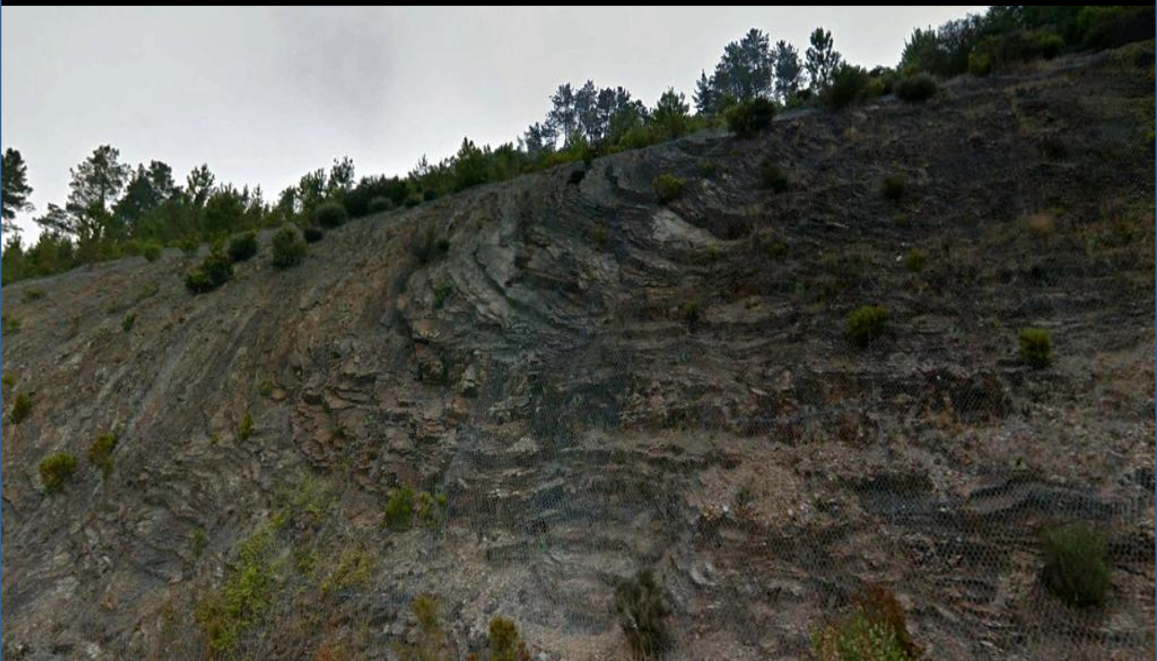
Detalle de anterior: Inestabilidad en plegamiento de Ordovícos. Mallazo. SW de A Borquería, Lugo. SW Hoja de Becerreá.
